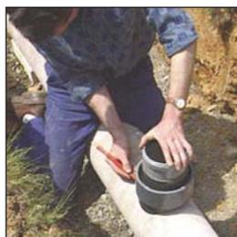
Repérer le point d'arrivée de l'antenne sur la canalisation.
