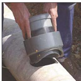
Faire un trou à la scie cloche (Ø 130 pour PVC 125, Ø 165 pour PVC 160 et Ø 205 pour PVC 200), puis vérifier l'emboîtement.
