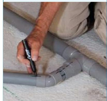
À l'aide d'un marqueur, tracer des repères sur les tubes et les raccords au niveau des jonctions de votre installation.
